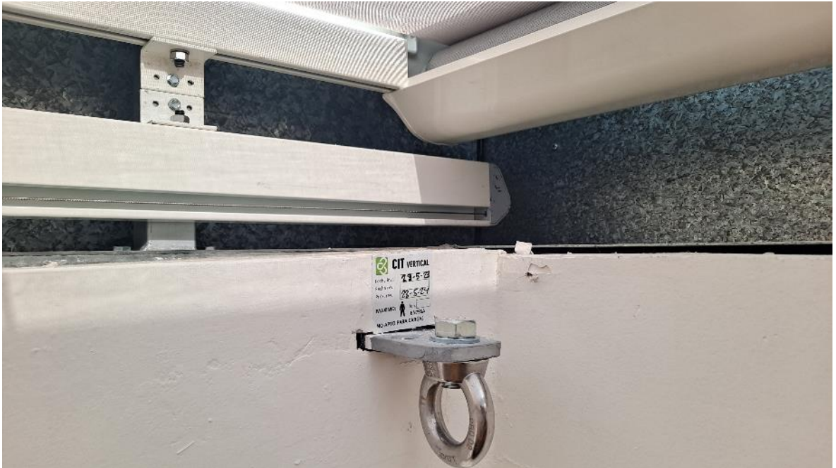
Ilustración 49. Detalle de anilla de anclaje
