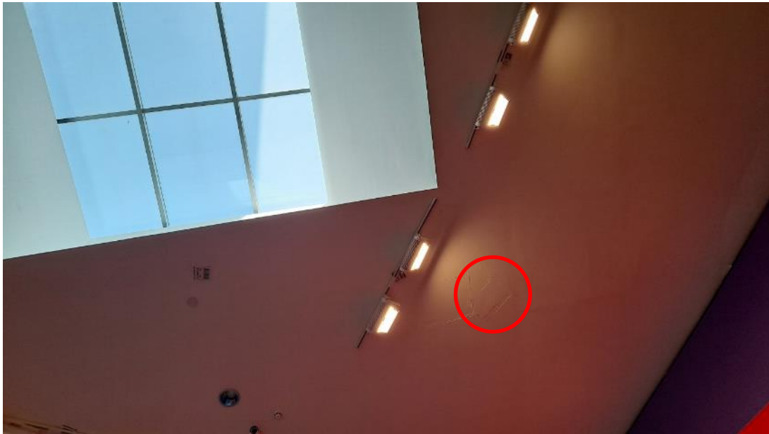
Ilustración 31. Ubicación de trampilla para controladores en 302 (bajo).
