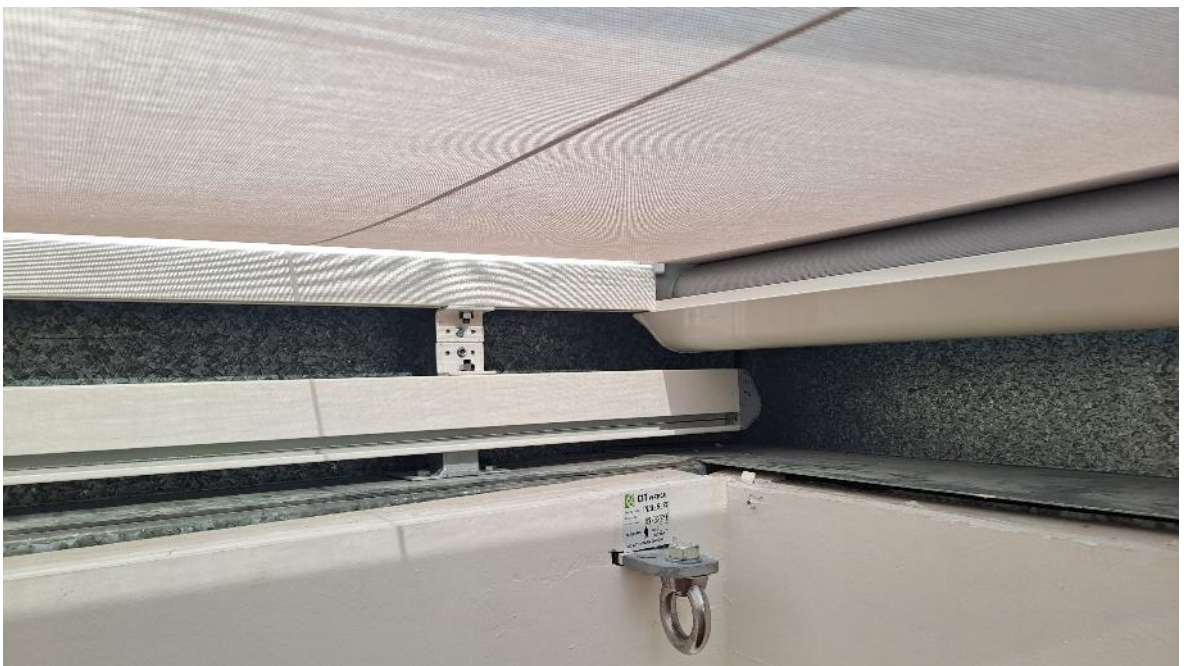
Ilustración 50. Ubicación de anclaje bajo carriles guía
