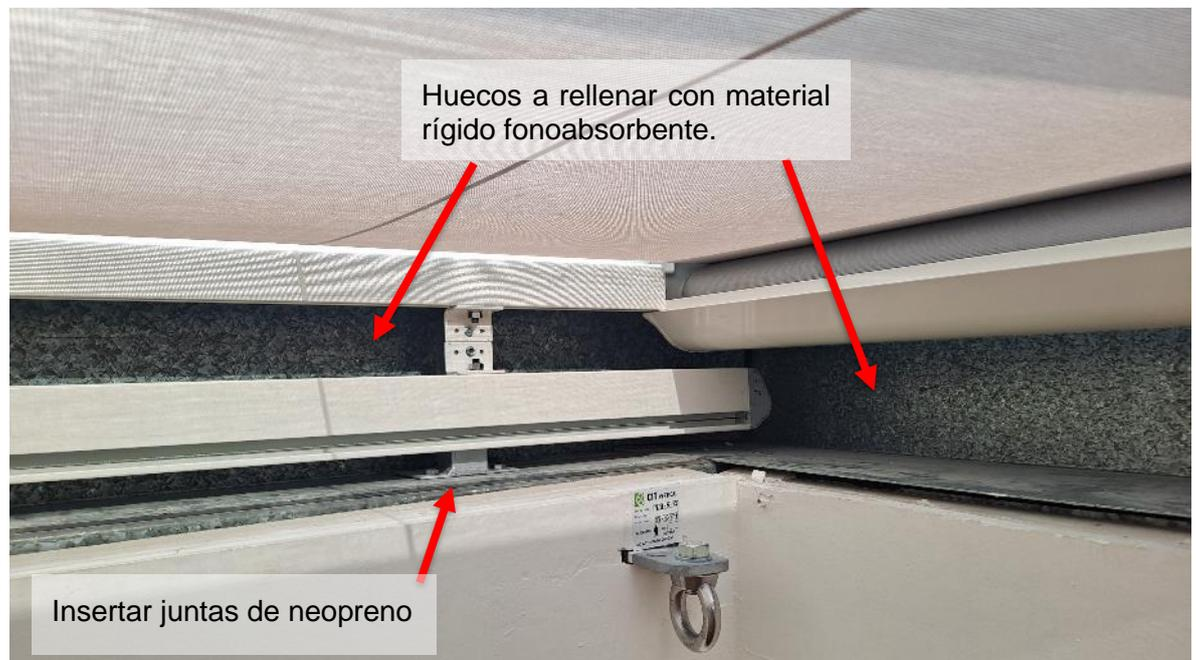
Ilustración 55. Esquema de medidas para reducción de ruido
