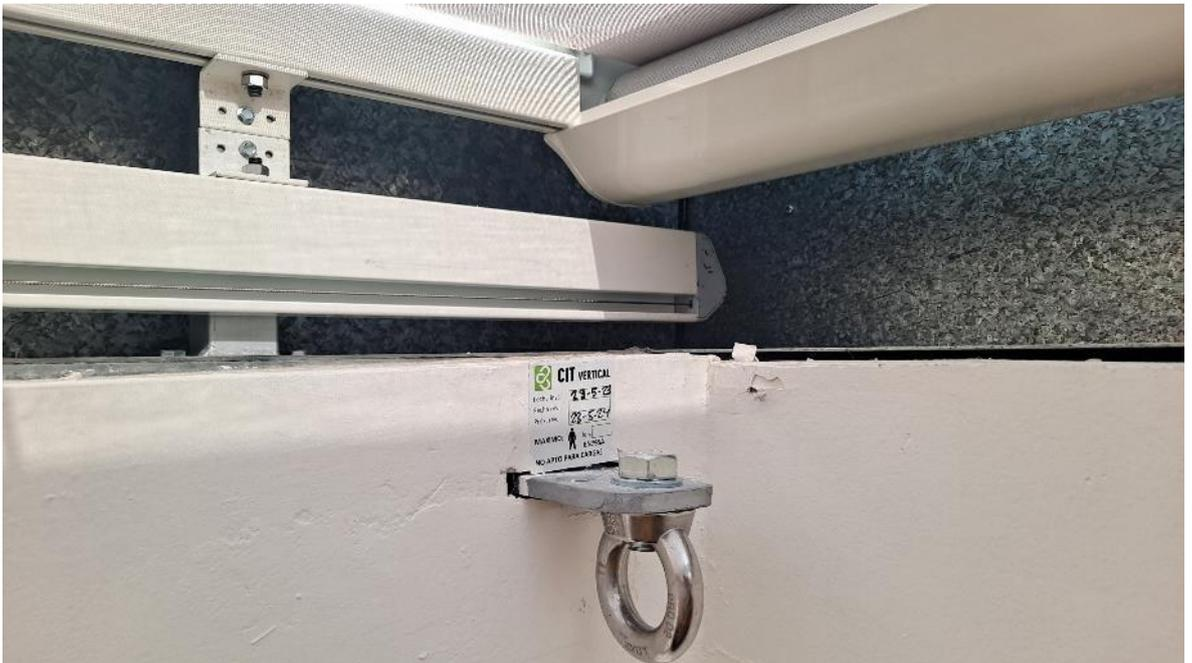
*Ilustración 49. Detalle de anilla de anclaje*
