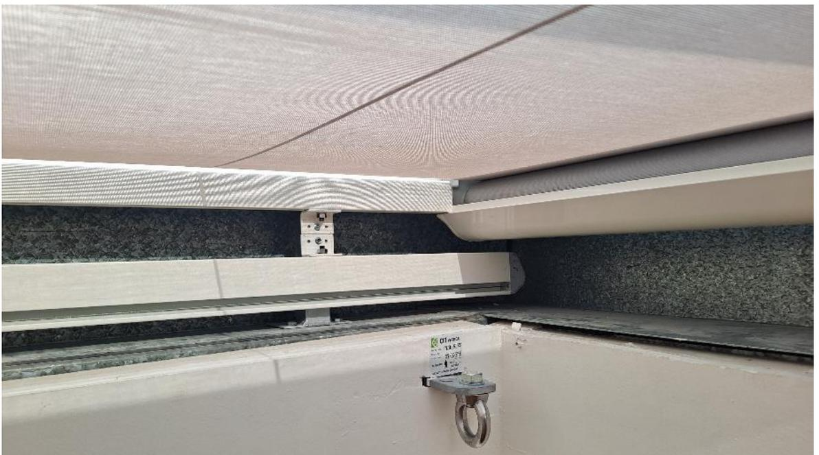
*Ilustración 50. Ubicación de anclaje bajo carriles guía*
