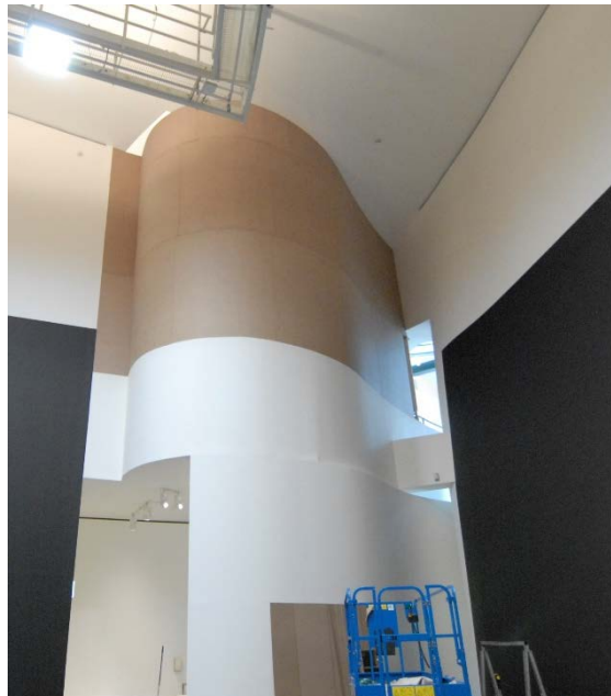
Ej. Forrado DM muro curvo
