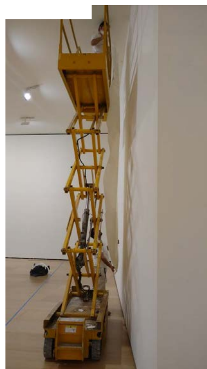
Ej. Colocación del velo de fibra de vidrio sobre pared
