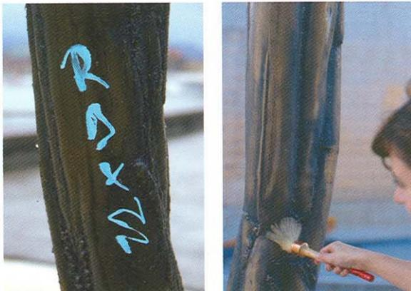
Figs. 7 y 8. Alteraciones producidas por agresiones. Aplicación de tratamientos de protección superficial
