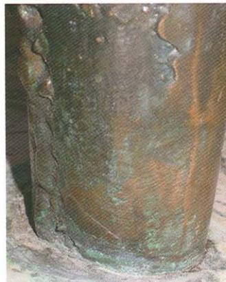
Fig. 9. Alteraciones localizadas en zonas de mayor retención de humedad
