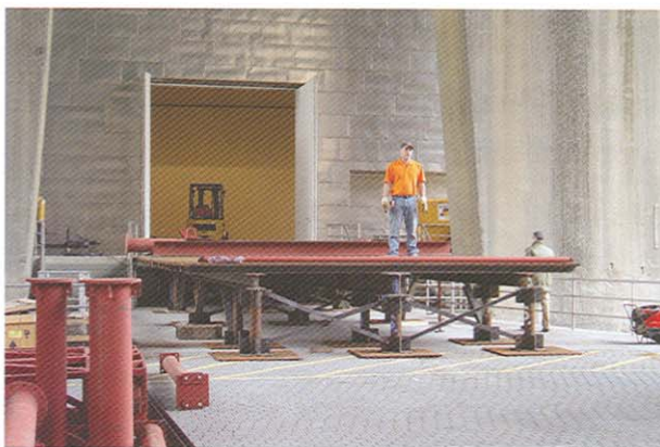
Fig. 9. Ampliación y refuerzo del muelle de carga
